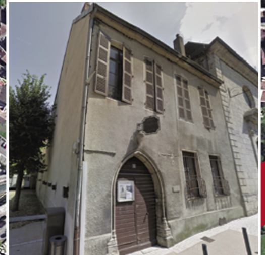
La maison de Jean Chousat, parcelle de 319 m2, appartient à la ville de Poligny. Cette maison est à l'abandon suite à l'invasion d'une méréule. Quel va être son devenir ?
